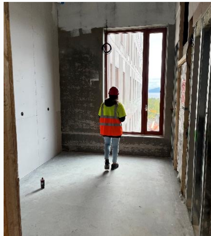
På bildet kan man se ett av de fire rommene som skal ha en akutt- og observasjonsseng. Bilde ble tatt på en befaring på Nye UNN Narvik i september 2022.
